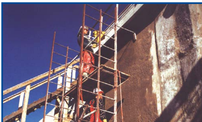
Проект: Пречиствателна станция за биологично третиране Ригас Уденс Местоположение: Рига, Латвия Дата: 1996 г.
