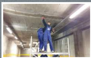
Полагане на PENETRON® INJECT, интегрална кристало-образуваща система за инжектиране в пукнатини
